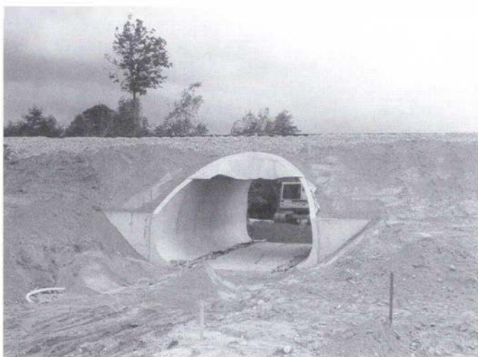
Nedlæggelse af overkorsler fortsætter ved privatbanerne. Den 26. - 29. juni 1998 etableredes en ny bro under OHJ umiddelbart nord for Højby. Fra fredag aften til lørdag aften blev dæmningen gravet bort. Fra lørdag aften til søndag aften etableredes den nye bro med betonelementer fra Perstorp. Mandag morgen kunne trafikken på banen genoptages. Fotos: Ole-Chr. M. Plum
