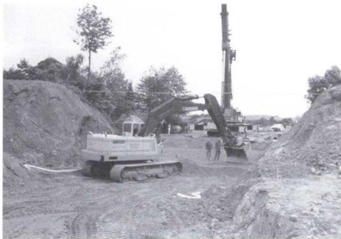
Nedlæggelse af overkorsler fortsætter ved privatbanerne. Den 26. - 29. juni 1998 etableredes en ny bro under OHJ umiddelbart nord for Højby. Fra fredag aften til lørdag aften blev dæmningen gravet bort. Fra lørdag aften til søndag aften etableredes den nye bro med betonelementer fra Perstorp. Mandag morgen kunne trafikken på banen genoptages. Fotos: Ole-Chr. M. Plum
