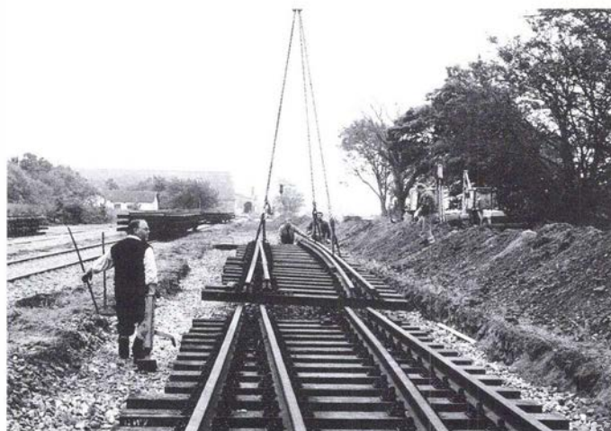
Ombygningen af sydenden af Høng station, søndag den 30. august 1998. Det nye sporskifte mellem spor 1 og 2 er ved at blive lagt på plads, hvorefter det nye spor mod Slagelse blev lagt. Foto: Ole-Chr. M. Plum
