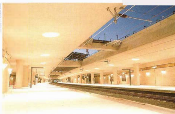
Københavns Lufthavn, Kastrup station
