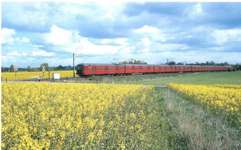
S-banen mellem Ballerup og Frederikssund står foran en større omvæltning i den kommende tid. Ombygningen til dobbeltspor vil betyde mange ændringer, hvorved banen som et led i omstillingsprocessen vil miste sine overkørsler. Snostrup, vest for Ølstykke den 18. maj 1991.
