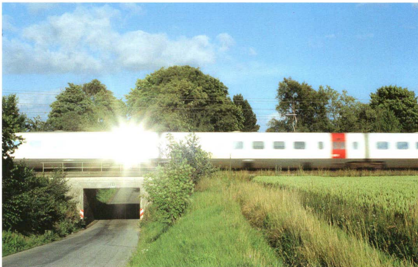
Hvornår mon denne lille underføring for Gammelgårdsvej ved Darup mellem Roskilde-Ringsted udvides til at bære yderligere to spor? Foto: Jan Forslund
