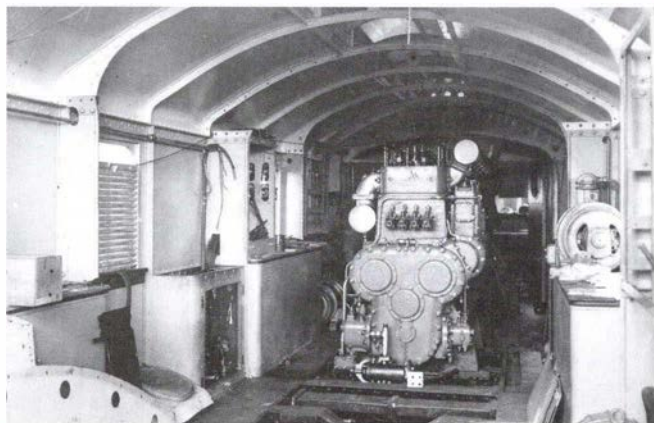
Den ene af de to motorer under indbygning i loko 553, juni 1931. Der er ikke meget plads i den smalle vognkasse Arkiv: JMJK
