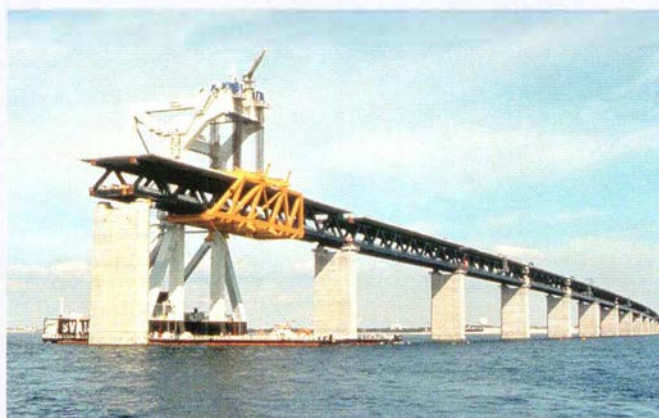
"Svanen" under montage af lavbrodel.
