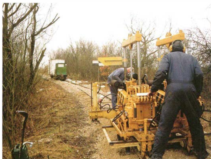
På billedet ses HVB's nye stoppemaskine i aktion ved km. 3.5, den 19. januar 1999. Stoppeenhederne er på billedet nedsænket i arbejdsstilling. I baggrunden ses baneafdelingens arbejdstog med lok M 9. Foto: Claus Nielsen
