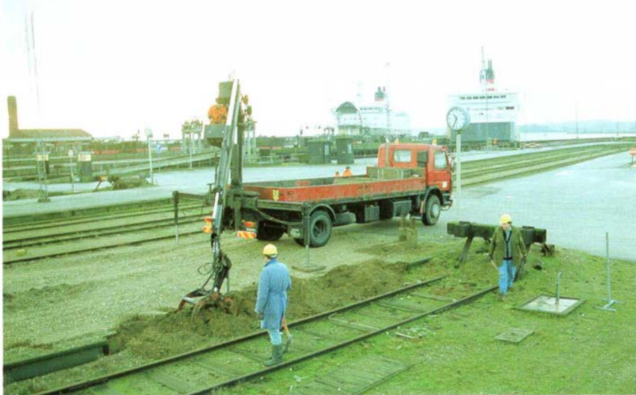
Bjærgning af perronforkanter i Nyborg Færge den 10. januar 1998. Igen var en kran uundværlig. Foto: Mogens Duus
