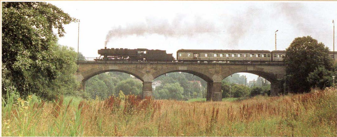
DB 050 603 på Jagstbrücke i Crailsheim med tog til Ansbach, den 4. august 1973
