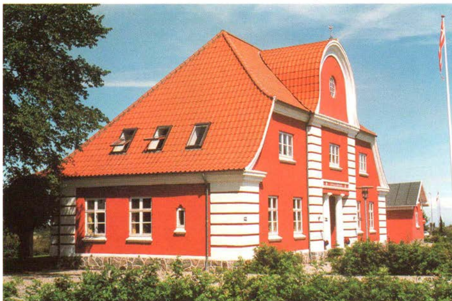
Spodsbjerg station i ny bemaling og indrettet til kontor for Scandlines' overfartsledelse på ruten Spodsbjerg-Tårs. Foto: Frank Nielsen
