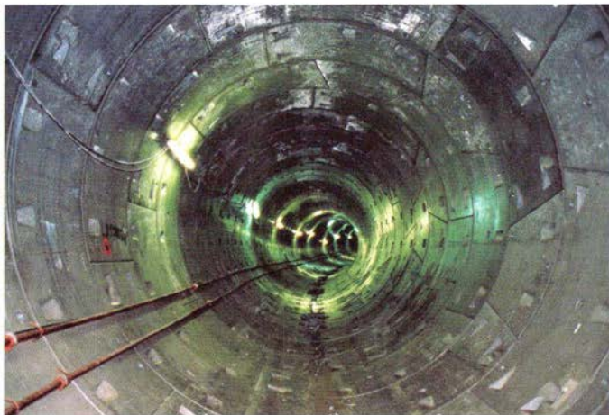
Tunnelskakt under Stadsgraven, set i retning af Universitets station, er nu klar til endelige sporlægning og etablering af sideperroner. Foto: René St. Olsen
