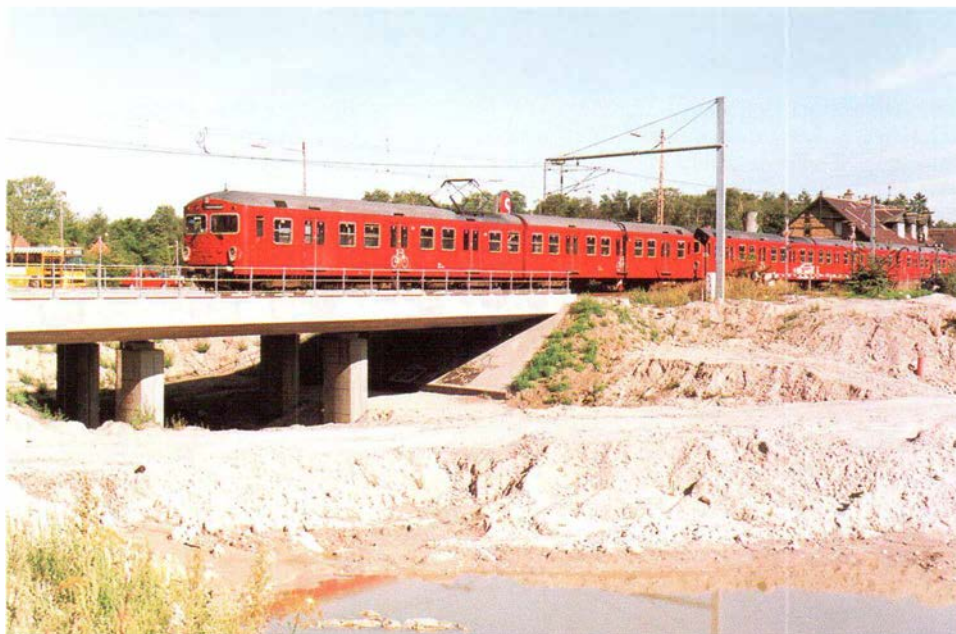
I Ølstykke er man nået langt med den nye vejunderføring der skal erstatte overkørselsanlægget i baggrunden. S-tog mod Frederikssund forlader her stationen den 3. september 1999. Foto: Allan Støvring-Nielsen
