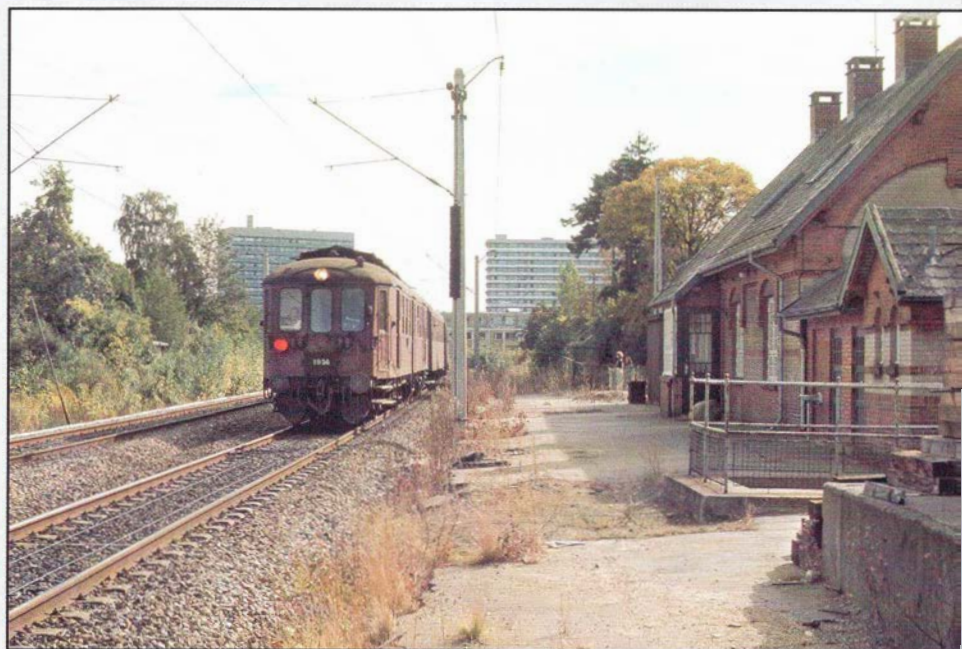
En epoke er slut. Her ses MO 1956 fremføre det sidste persontog mod Farum under passage af den gamle Bagsværd station, den 24. september 1977.
