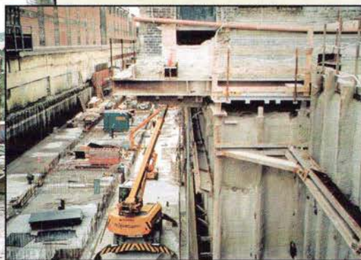
Dele af den gamle station svæver frit over byggepladsen. Foto: Bent Jacobsen
