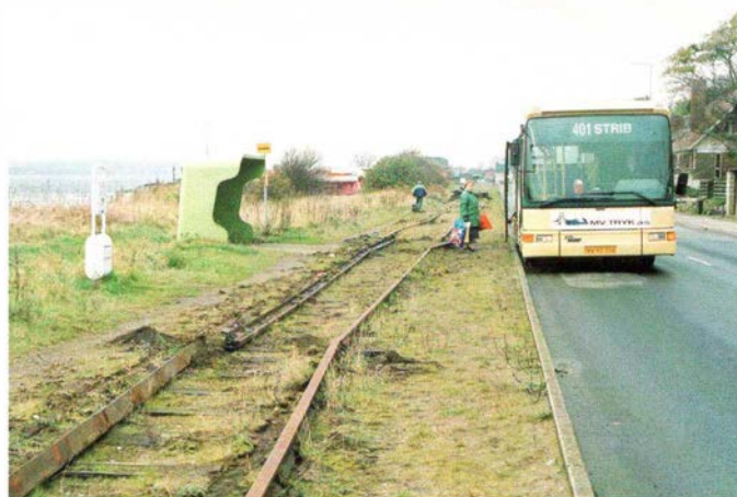
Timeglasset er nu rindet ud for Middelfart-Strib banen. Her er sporet ikke længere farbart og buspassagererne må skræve over resterne. Foto: Allan Støvring-Nielsen
